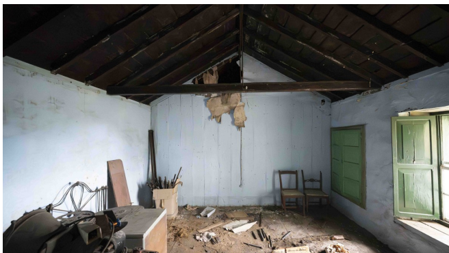
Salon - Vista 1: techo madera tea a dos aguas
